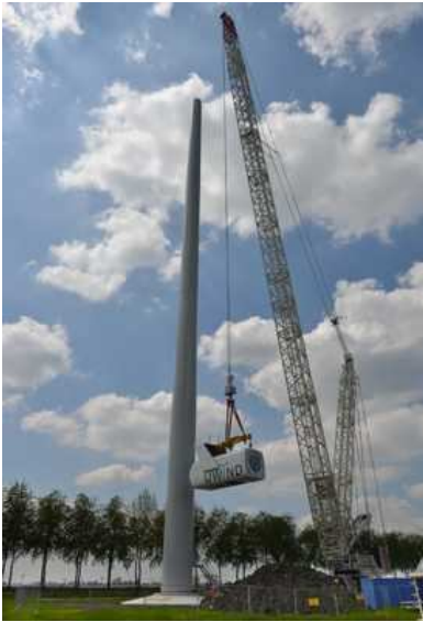
De bouw van de eerste van de drie molens in Windpark Houten. FOTO WILLIAM HOOGTEYLING
